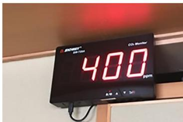
L'hôtel est équipé avec des appareils de mesure de concentration du CO<sub>2</sub>, dans le cadre de nos mesures de ventilations d'air. (Nous nous assurons que cette valeur ne dépasse normalement pas le standard de 1000ppm)
